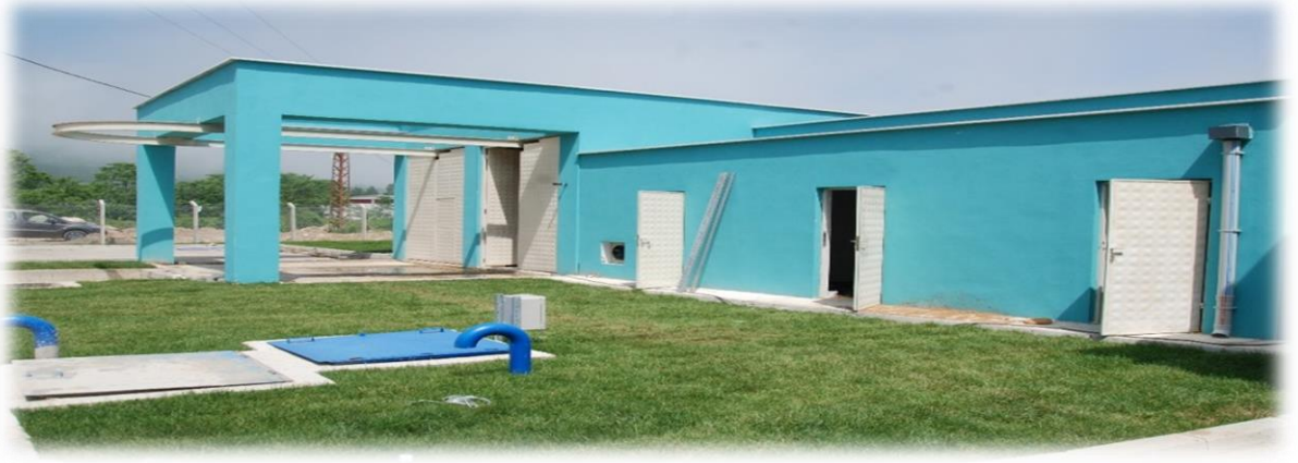
İçme Suyu Ana Depo ve Klorlama İstasyonu(DY1)
