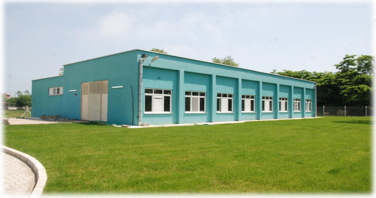
İçme Suyu Ana Terfi İstasyonu(TMY1)
