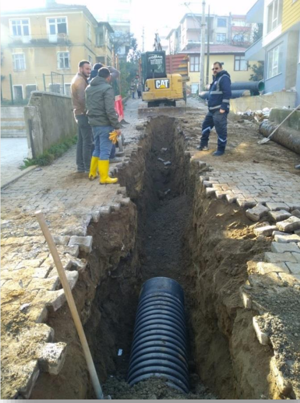
Yağmur Suyu Hat İmalatı Çalışmaları
